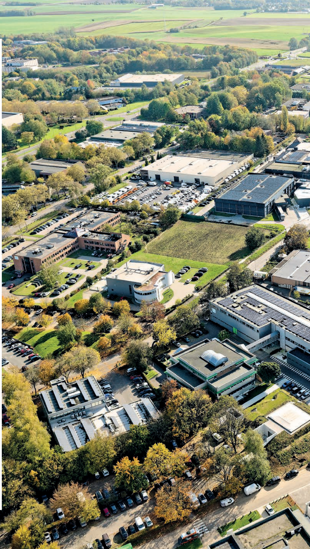
Vue aérienne du siège d'IBA et de la Beam Factory, 2023.
